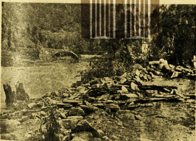
Разрушенъ мостъ при с. Стокитъ, Севлиевско — наводнението презъ 1939 год.
